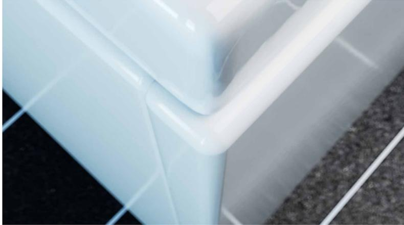
**Achtung:** Die Seitenverkleidung muss am Boden entlang mit Silikon abgedichtet werden. Dies dient nicht nur zum Abdichten des Bodenbereichs, sondern fixiert außerdem noch einmal zusätzlich die Seitenverkleidung. Die Verkleidung sollte aber nicht vollständig versiegelt werden! Die Abdichtung am Boden entlang reicht aus. Nur so kann für ausreichend Luftzufuhr gesorgt werden.
