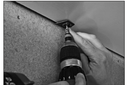
Leistenclip montieren
