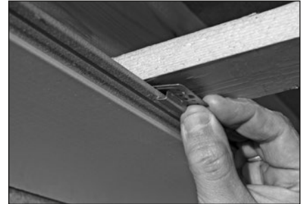
Befestigungskralle setzen
