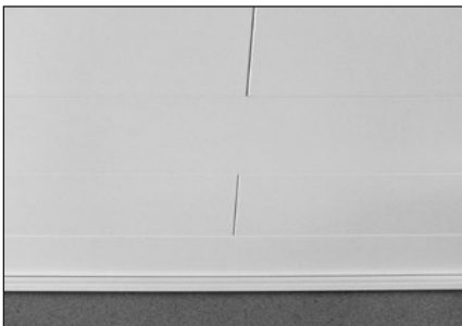
Deckenabschlussleisten aufstecken – fertig
