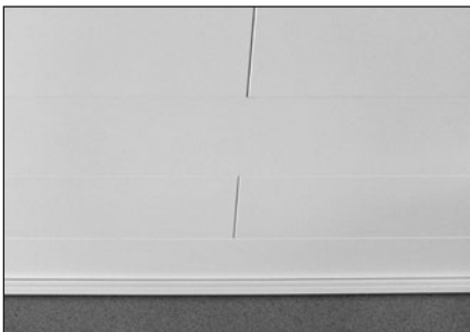
Deckenabschlussleisten aufstecken – fertig
