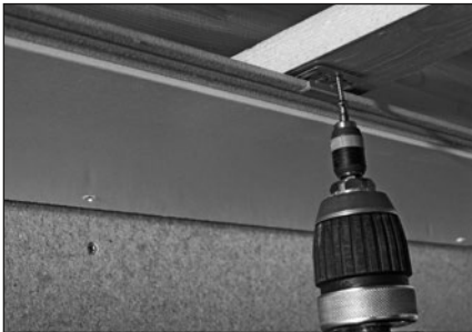
Befestigungskralle anschrauben
