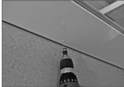
Erstes Steck-Paneel befestigen
