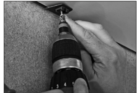
Leistenclip montieren
