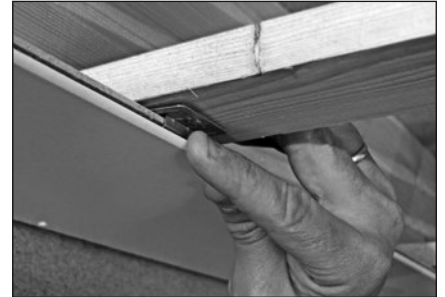
Befestigungskralle setzen
