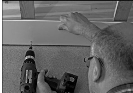
Erstes Steck-Paneel befestigen
