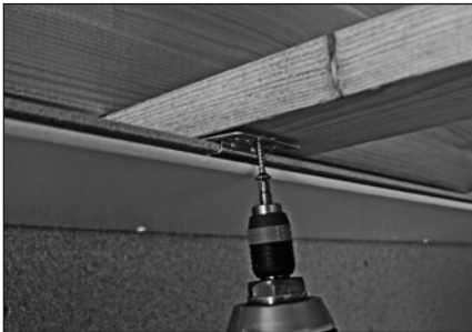
Befestigungskralle anschrauben
