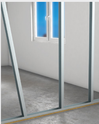
Montage der CW-Ständerprofile
