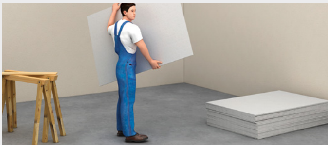
Einzelne fermacell Gipsfaser-Platten hochkant tragen
