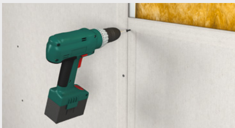
Schrauben auf Stahl-Unterkonstruktion
