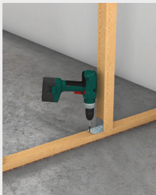
Montage der Holzständer mit Stiftnagel oder Stahlwinkel
