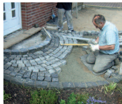
Verlegen von Kleinpflaster in PCI Pavifix DM.
