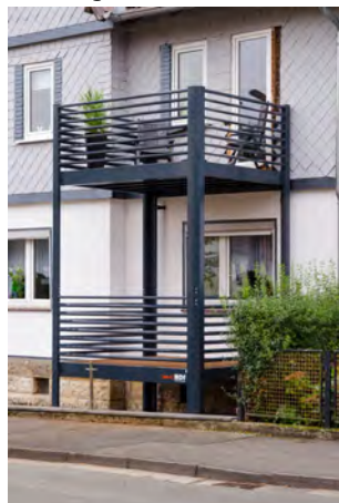
2-fach Balkon mit Pulverbeschichtung (RAL 7016) und Lamellengeländer.
