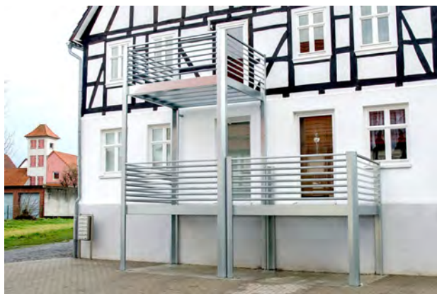
Verzinkte Balkonanlage mit mehreren Balkonen über- und nebeneinander (mit Lamellengeländer)
