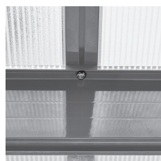
Sparrenverschraubung Edelstahl Schrauben/Muttern
