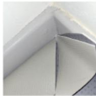
4. Schnitt wie auf der Abbildung gezeigt setzen und Produkt aufklappen.
