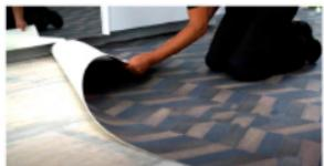
3. Empfohlene Trocknungszeit abwarten und Bodenbelag auf den vorbereiteten Unterboden zurückklappen.
