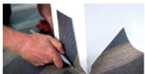
6. Wenn das Material nun flach an den Ecken und um Installationsteile anliegt, kann mit dem Abschneiden an den Wänden begonnen werden.
