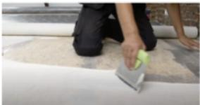
2. Kleber gemäß den Anweisungen des Klebstoffherstellers auf den Unterboden auftragen.
