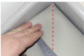
2. Messerspitze in der Ecke ansetzen und bis zur Produktkante schneiden.
