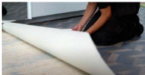
1. Erste Hälfte des Bodenbelags zurückklappen, um etwa die Hälfte des Unterbodens freizulegen.
