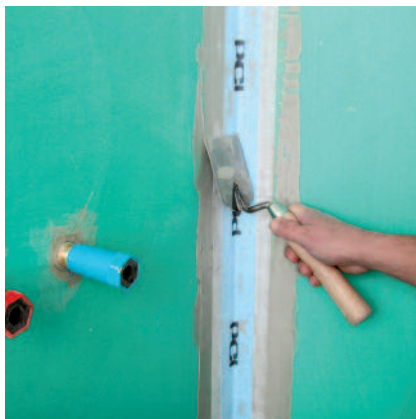
... und nachfolgend mit leichtem Druck eingebettet.
