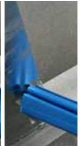
Aufstecken der Bodenschiene am Stahlträger
