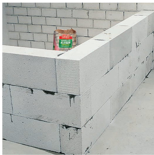
Mit SICHERHEITSKLEBER PORENBETON geklebte Wände.
