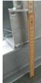
Einbautiefe des Stahlträgers (ca. 22,5 cm)
