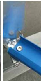
Montage des Bodenschienen- Anschluss-Stückes
