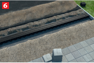
6 Den kompletten Rinnenstrang an die gewünschte Stelle setzen.
