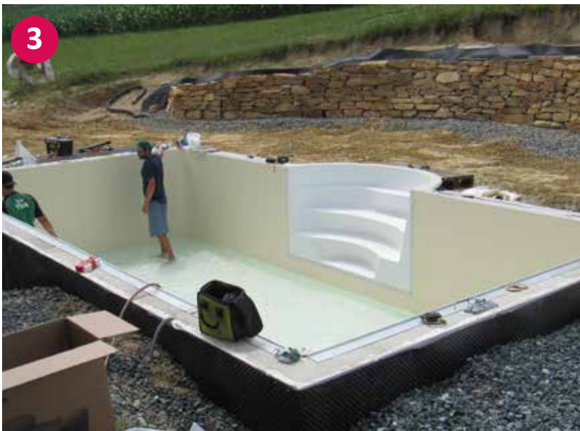
▲ Einhängen des Foliensacks und Anflanschen der Einbauteile
