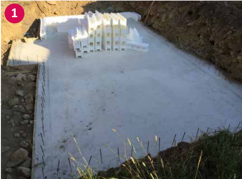
▲ Fertig ausgehärtete Bodenplatte
