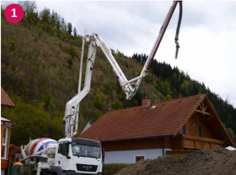
▲ Betonwagen mit Betonpumpe und Fallbremse
