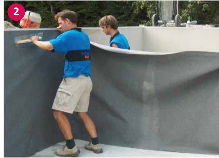
▲ Punktuelle Befestigung der Vliestrennlage mittels Styroporkleber
