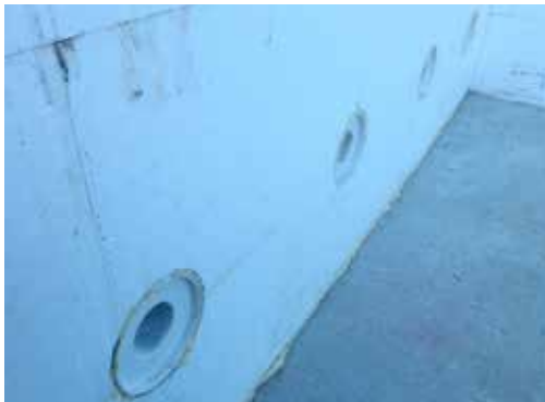
▲ Fertig eingeschäumte Wanddurchführung
