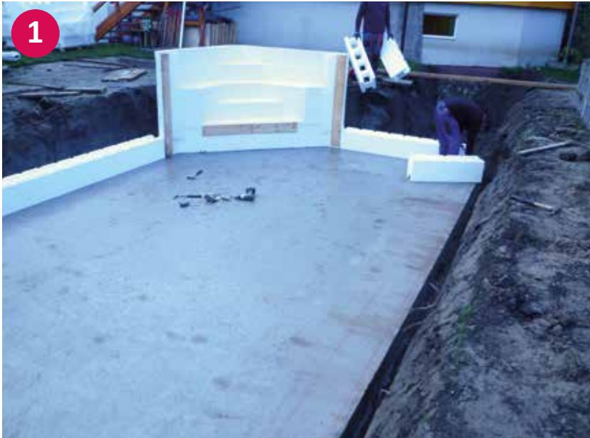
▲ Ecktreppe mit erster Ansatzreihe Styroporsteine
