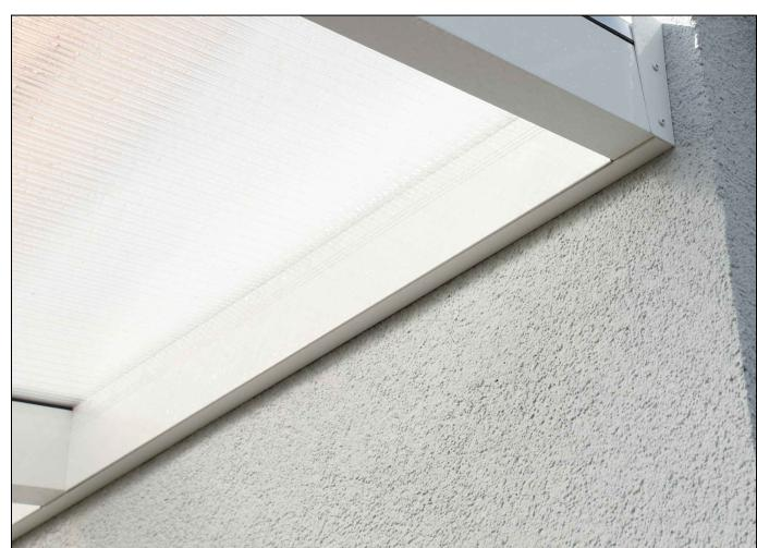
Bringen Sie die Blendleisten mit dem Klick-System an. Nach erneutem Ausrichten der Konstruktion verfüllen Sie die Fundamentlöcher mit Beton und lassen ihn härten bevor Sie mit der weiteren Montage fortfahren.
