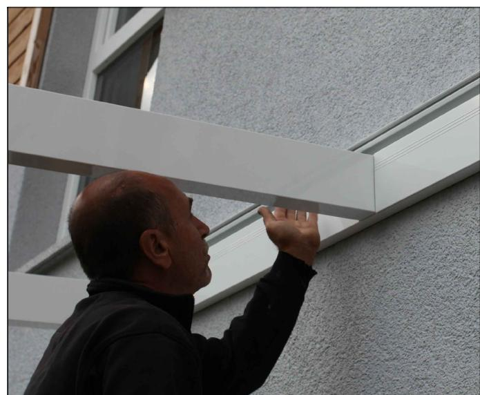
Verteilen Sie die anderen Sparren mit Hilfe der Blendleisten (dienen als Abstandshalter), bohren Sie die Schraublöcher mit einem 4mm Metallbohrer vor und verschrauben Sie die Sparren mit jeweils einer Karosserieschraube (C101-025) an den beiden Pfosten.
