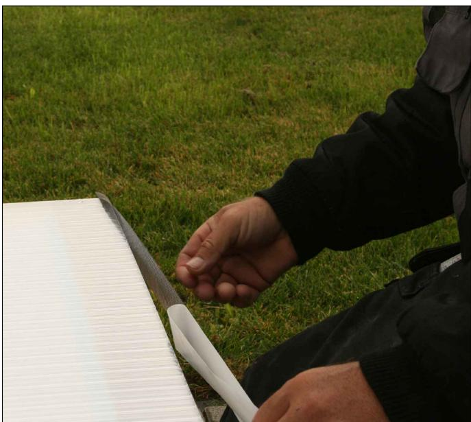
Die Doppelstegplatten von der Schutzfolie befreien (Achtung Oberseite beachten!) sowie im vorderen und hinteren Bereich mit Dichtband versehen.
