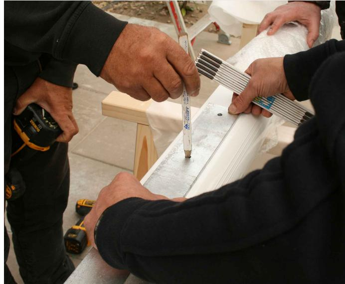
Zeichnen Sie die mit Gewinde vorgebohrten Schraublöcher der einzelnen Pfostenlaschen an die jeweiligen Pfosten an.
